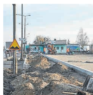
Widać znaczny postęp w pracach budowlanych
